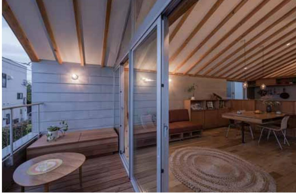
ロジアからリビング・ダイニング・キッチンを見る。窓サッシは床面に収め、内外のレベル差をフラットにしている。
