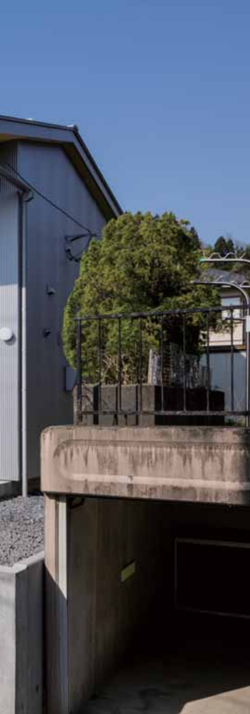
東側外観。大きな開口部から室内に外光を取り入れる。
