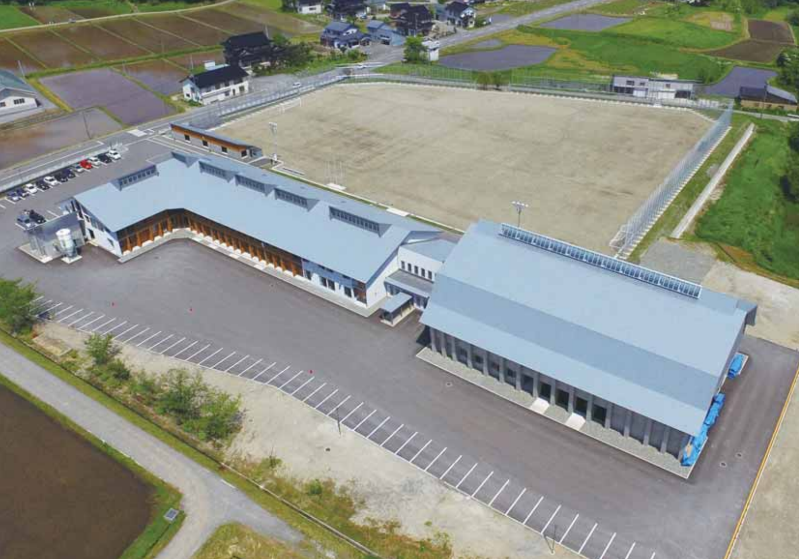
左側が校舎棟。渡り廊下で繋がった右側が屋体棟。
