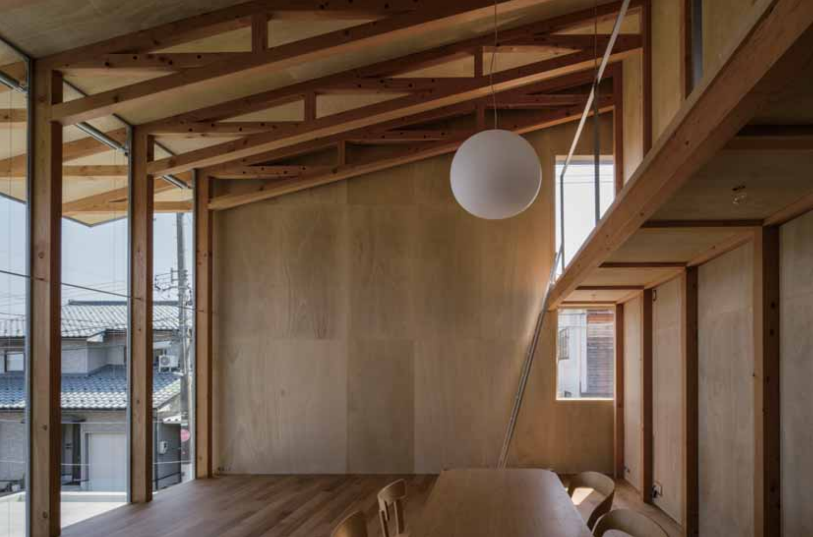
2層吹き抜けのリビングダイニング。壁天井はラワン合板、床はタモ材フローリング仕上げ。右手には2階の予備室・書斎と繋がるキャットウォークを設けた。
