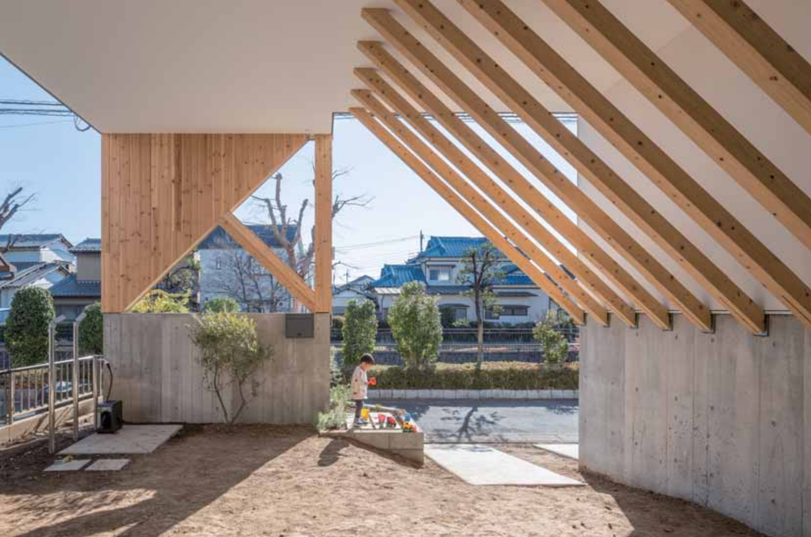
ニワ。1階ニワの天井高は3,695mm。角ヒバの方杖が2階を支える。
